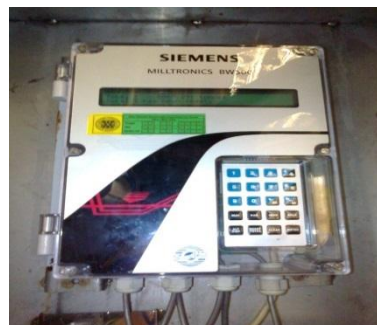
Gambar 12. Alat pembaca kecepatan belt conveyor
